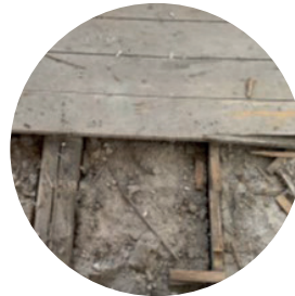
Isolering og støv under gammelt gulv
