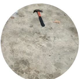
Betongulv med olie
